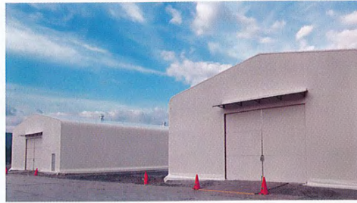
施工例: テント倉庫
