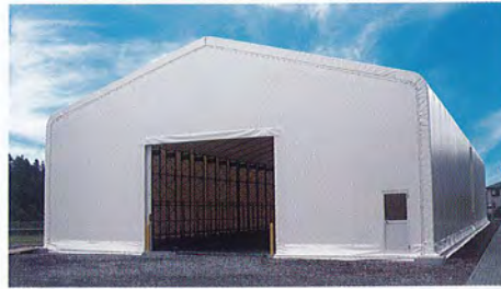
施工例：テント倉庫
